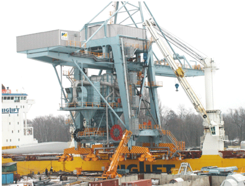
Entstaubungsanlage für Schüttgutverladung im Hafen von Fremantle
